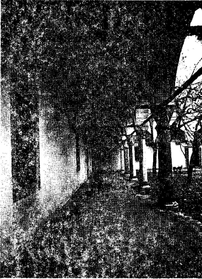
Resim 15. İmaretin avlu revakı
