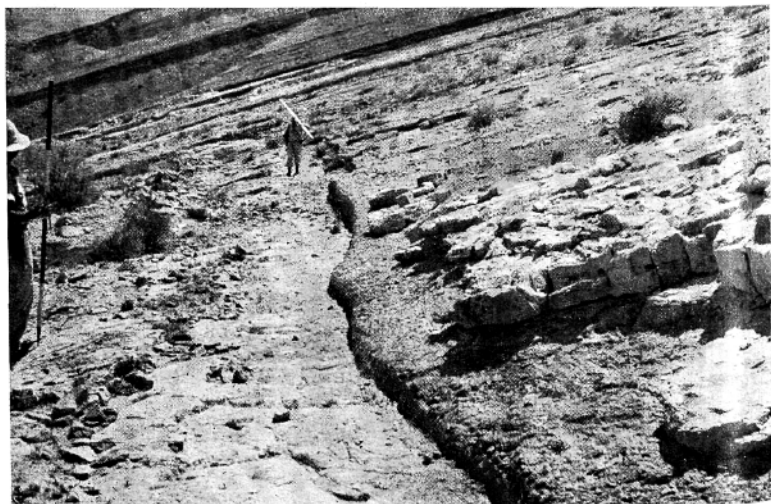
2. הכביש החצוב בסלע בניצב למדרון המתלול
