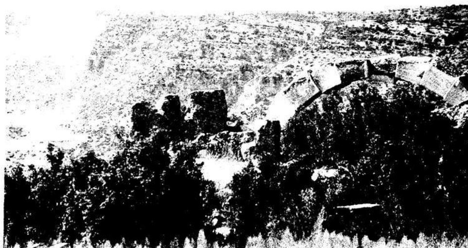
Fig. 2: Le bâtiment annexe.
